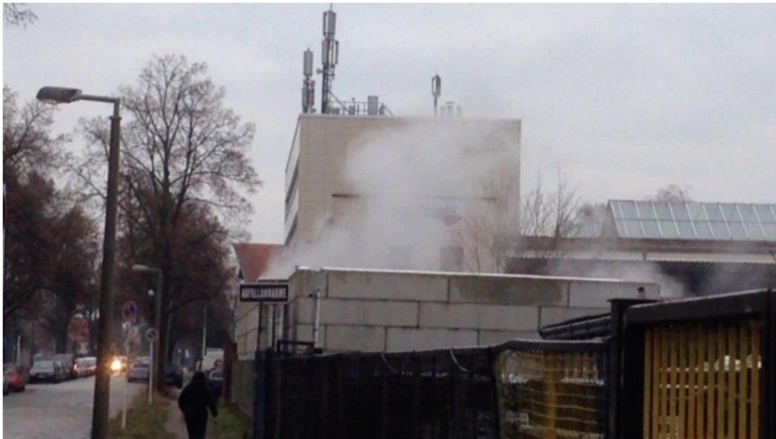
Bild: Belästigung durch Staub infolge Bauschutt-Umladungen
