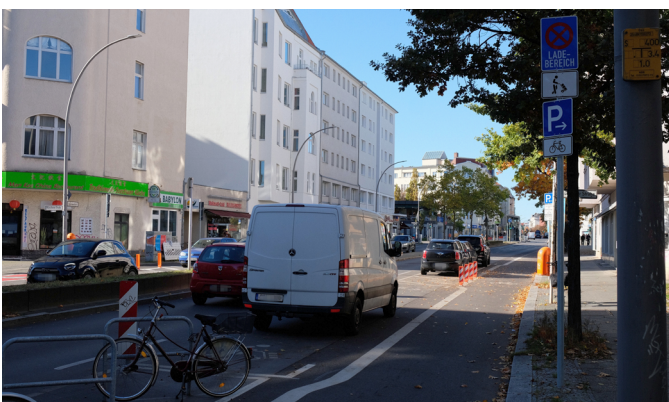
I.5 Lade-/Lieferzone kombiniert mit Anlehnbügel, Fußgänger-Aufstellfläche und geschütztem Radfahrstreifen auf der Grunewaldstraße in Berlin-Schöneberg.
