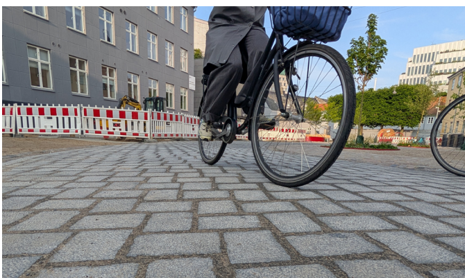
F.5 Geschnittenes Pflaster für Komfort beim Radfahren und zu Fuß Gehen über einen Platz in Aarhus.
