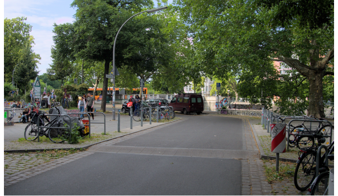
E.2 Anhebung zur Temporeduktion vor einem Schuleingang mit starkem Querungsbedarf von Menschen zu Fuß. Weichselstraße, Berlin Friedrichshain-Kreuzberg.
