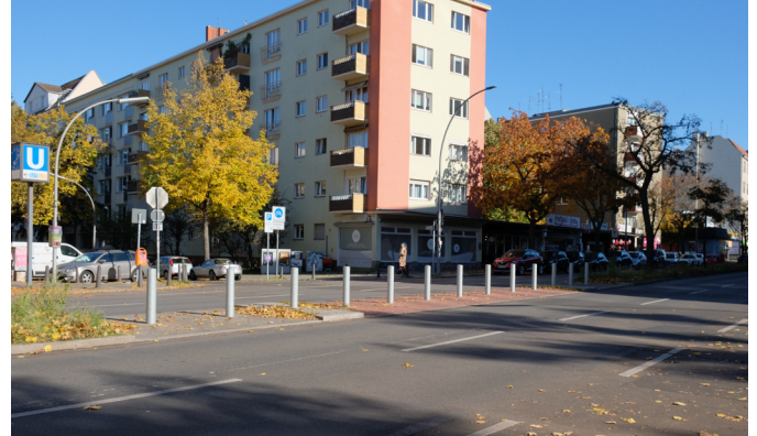
I.2 Sichere Querungsstelle für den Fuß- und Radverkehr im Mittelstreifen einer Hauptverkehrsstraße. So kann eine Fahrradstraße über mehrere angrenzende Superblock-Quartiere durchgeführt werden.
