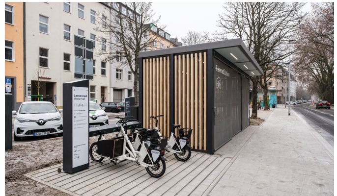
H.4 Mobilitätsstation mit Lastenrad- und Carsharing sowie Sammelschließanlage für Fahrräder in Düsseldorf.
